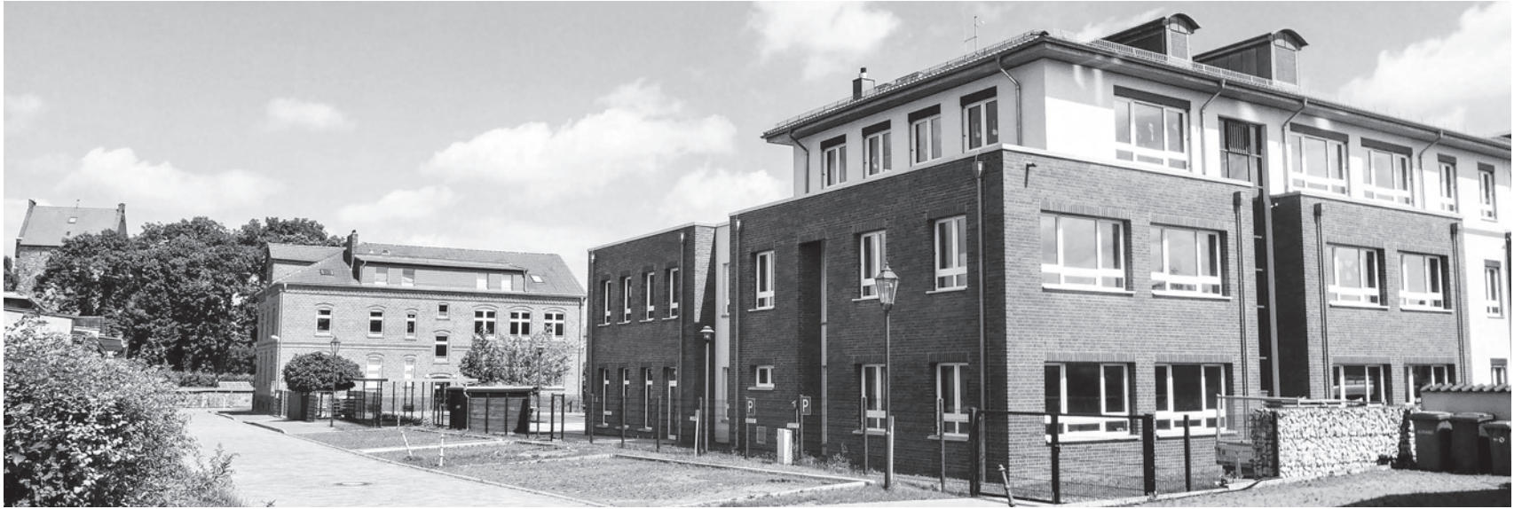
Heute schon ein interessanter Campus: Grundschule Blumberg (rechts), dahinter im alten Schulgebäude das Schulmuseum. Dieses Ensemble wird nun zu einer Grundschule mit weiterführender Schule umgestaltet. Foto: F. Müller
